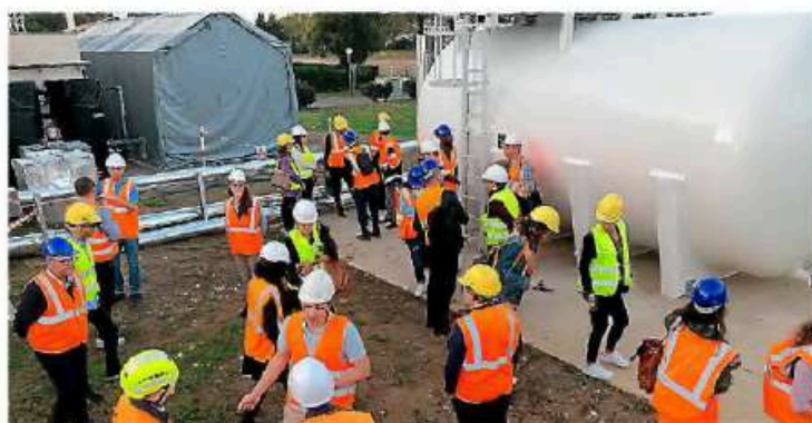
L'unité de réutilisation des eaux usées est en fonctionnement depuis juillet dernier.
