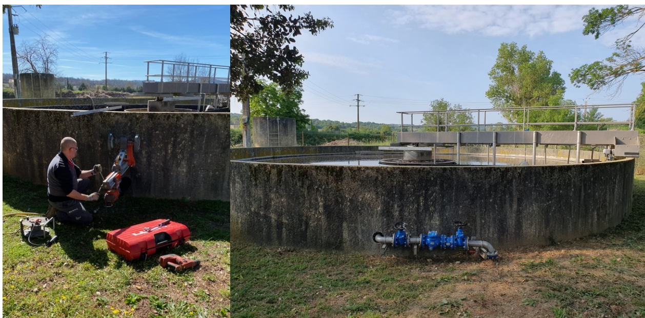
Figure 1 : Perçage et système de vannes sur le clarificateur
